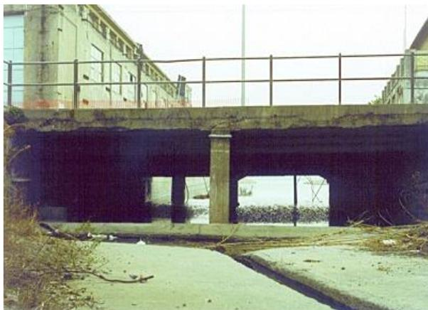
*Figura 2.6.1.5 Rio Molinero – Ponte dell'Aurelia visto da monte. Si osservi, rispetto alla figura precedente, il diverso assetto dell'impalcato, la ringhiera, la pila centrale e la plateazione in calcestruzzo*
