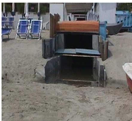
*Figura 2.6.2.14– Fosso colatore S. Cecilia: sezione di sbocco a mare. Da notare la regolarizzazione della bocca ottenuta con muretti in c. a.*
