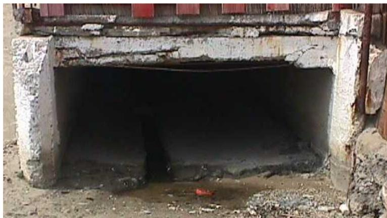
Figura 2.6.2.18 – Fosso colatore S. Antonio: sezione di sbocco. Da notare il degrado del calcestruzzo della copertura del cunicolo, ove si può vedere che ormai il copriferro è interamente consumato esponendo così il ferro delle armature agli agenti atmosferici.
