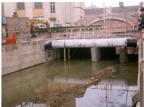
*Figura 2.6.1.4 Rio Molinero – Ponte sulla Via Aurelia visto da valle. Si osservano le tubazioni poste all'altezza dell'impalcato del ponte. In lontananza si scorge il ponte antico a schiena d'asino*
