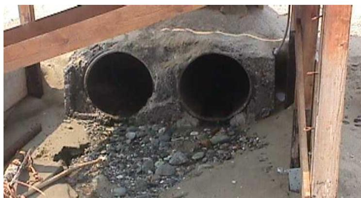
Figura 2.6.2.17 – Fosso colatore della zona Deposito Locomotori FF.SS.: sbocco a mare nella spiaggia dei Bagni Italia.
