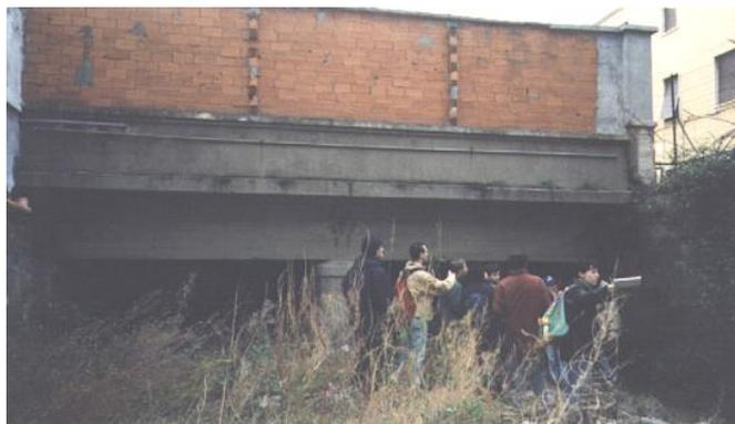
*Figura 2.6.1.1 Rio Molinero - Imbocco della passerella di accesso al polo Accademico, si noti la spessa pila centrale e le ridotte dimensioni della luce e, in sponda destra, la rete metallica che sostituisce il muro crollato durante la piena del 25 settembre.*
