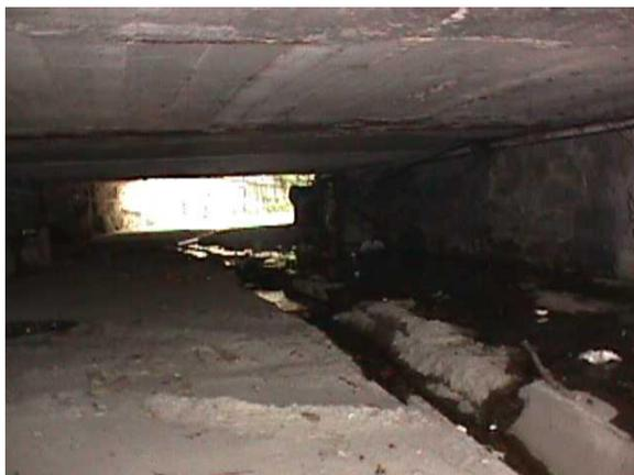
*Figura 2.6.2.11- Rio delle Quattro stagioni: particolare della sezione sotto il ponte dell'Aurelia: è determinabile visivamente la riduzione della sezione del rio*
