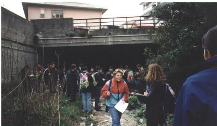
*Figura 2.6.1.2 Rio Molinero - Imbocco della copertura del parco ferroviario. l'alveo ha sezione rettangolare, ma procedendo verso valle si possono osservare quattro cambi di sezione*
