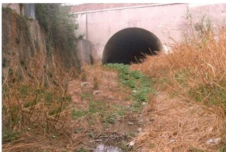
*Figura 2.6.1.3 Rio Molinero - Sbocco della copertura del parco ferroviario: si osservi l'alveo ingombrato dalla vegetazione. Il tratto si trasforma in caso di piena in una vasca di ferma.*
