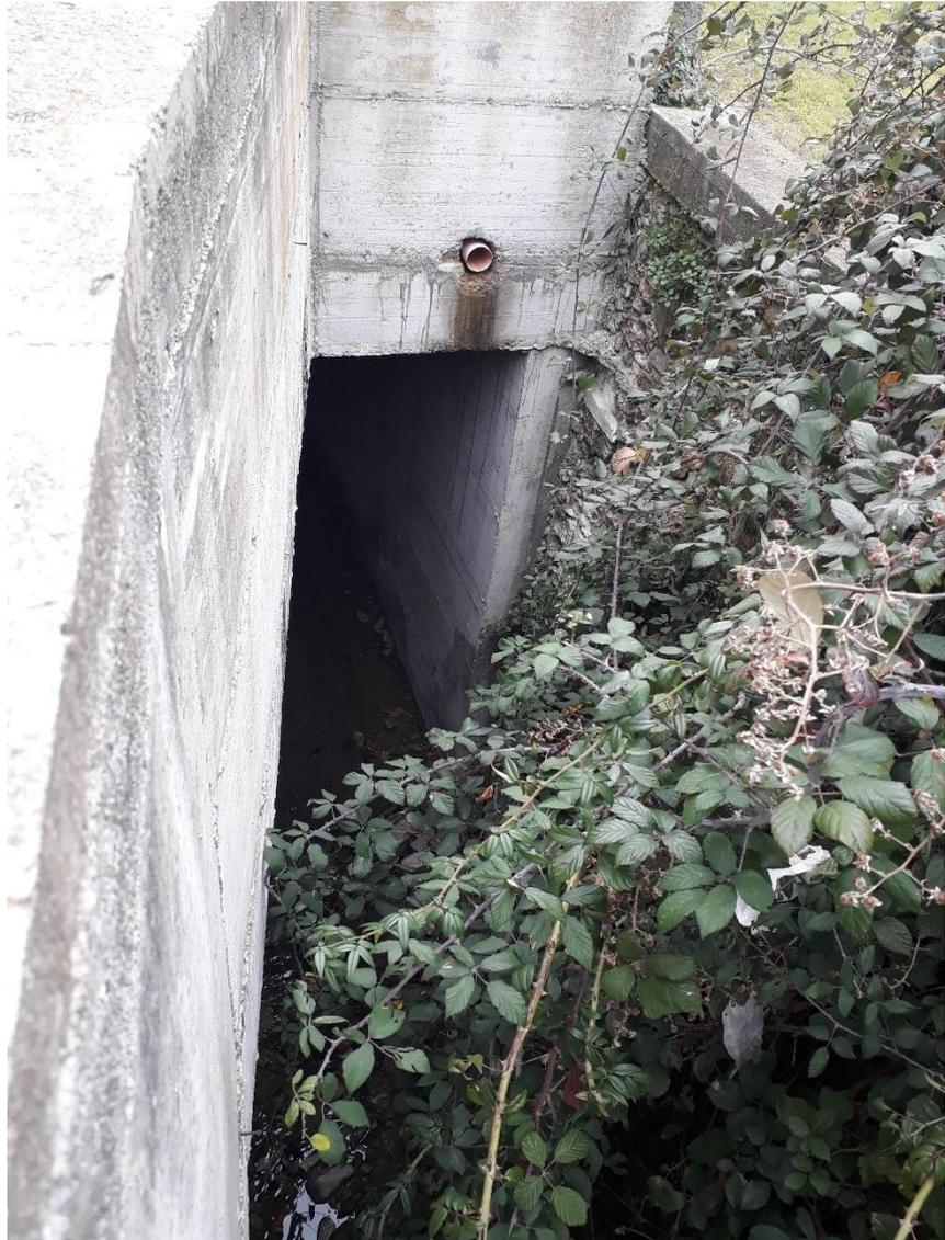
Figura 1.4 Sbocco della tombinatura di monte in prossimità di via Mangano.
