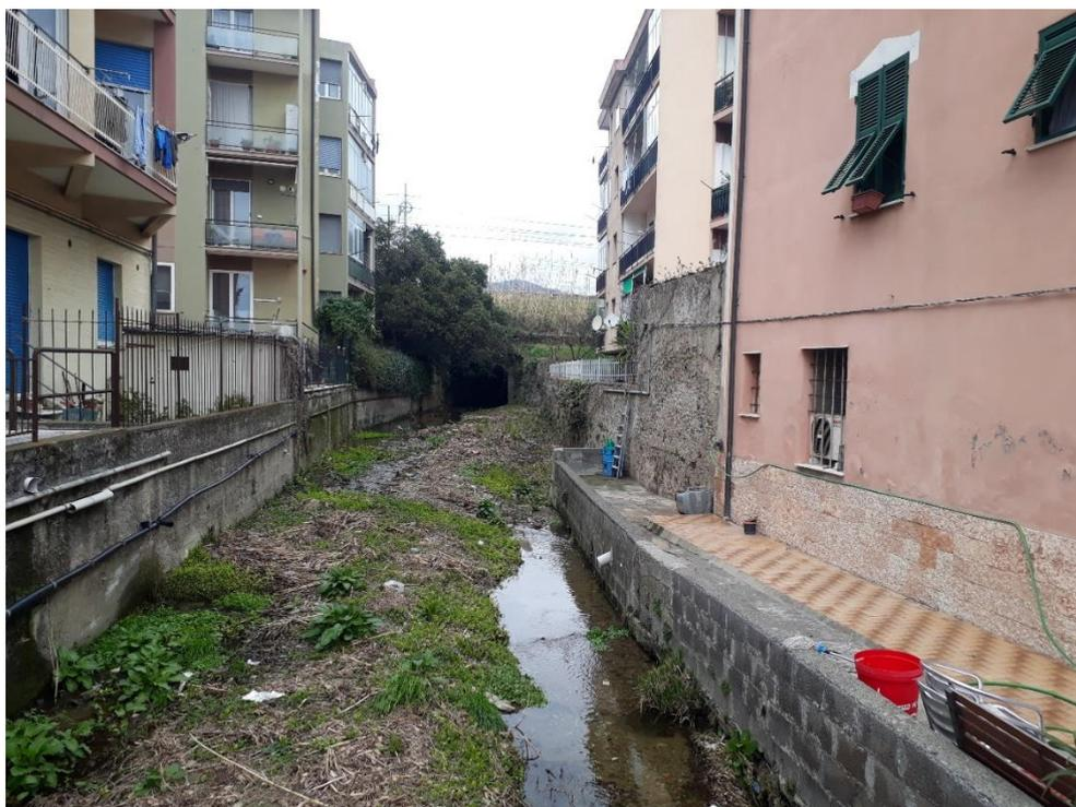
Figura 1.8 Tratto a valle della tombinatura in prossimità della ferrovia, fotografato da via Nizza. La porzione di destra dell'alveo risulta particolarmente interessata da fenomeni di deposito alluvionale.
