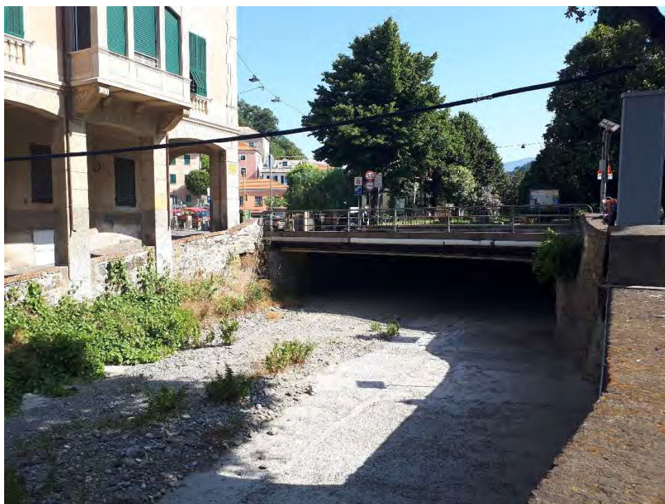
Foto 2.11: Rio Basco sbocco tombinatura del Comune
