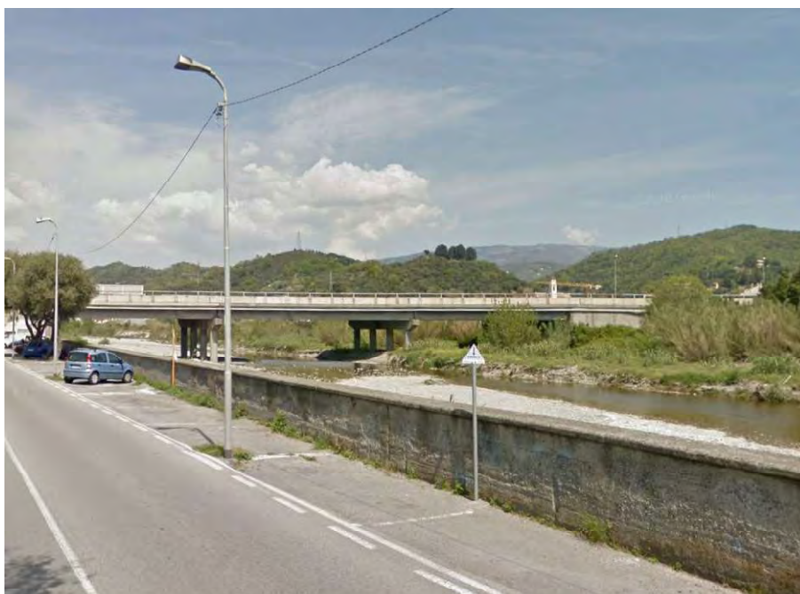
Foto 2.4: Torrente Sansobbia a valle dell'attraversamento autostradale (via Faraggiana)
