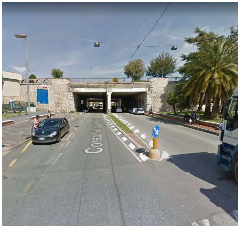
Foto 2.21: Sottopasso di corso Mazzini verso monte
