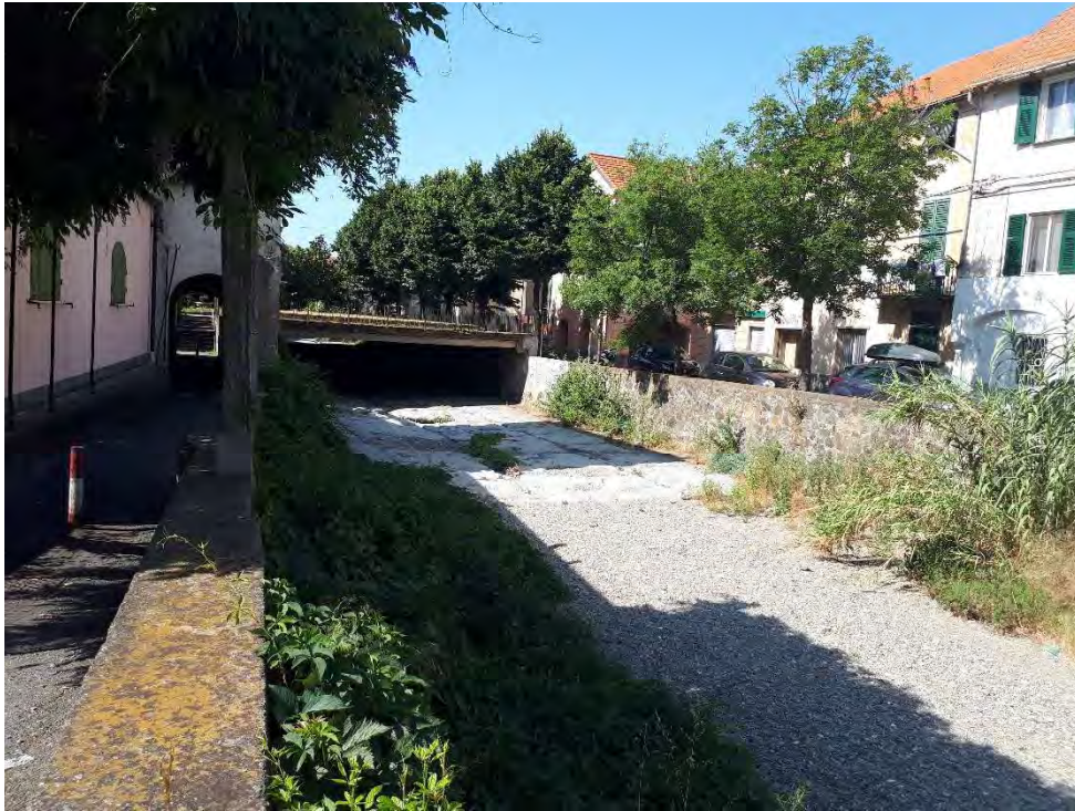
Foto 2.12: Rio Basco imbocco tombinatura del Comune
