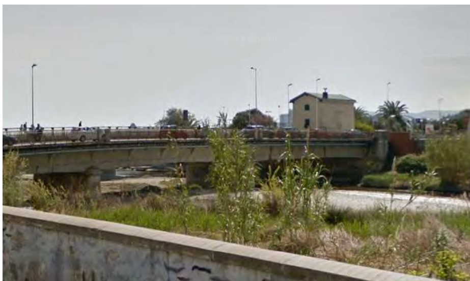
Foto 2.5: Torrente Sansobbia a monte dell'attraversamento SS1 via Aurelia
