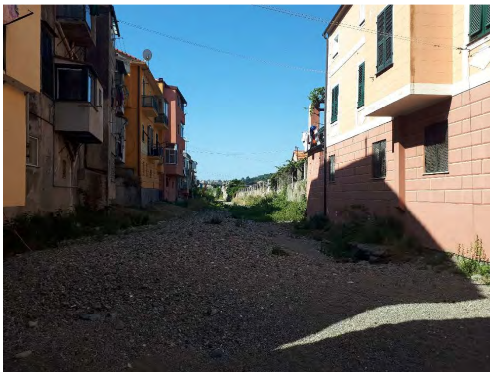
Foto 2.10: Rio Basco a valle dell'attraversamento del ponte medioevale
