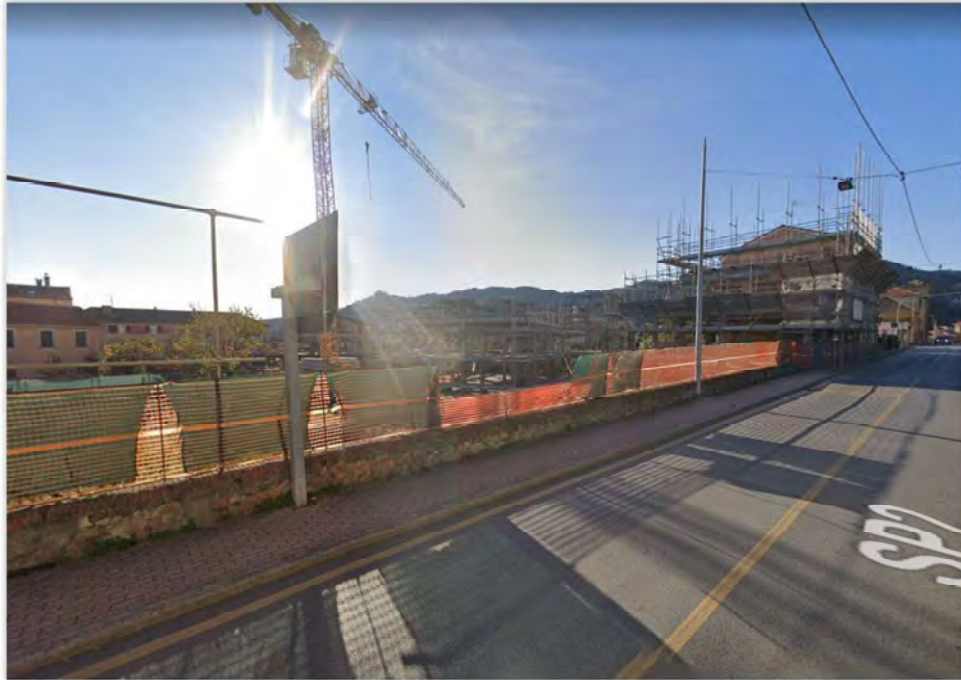
Figura 2.4 – Foto Edifici in costruzione tra Corso Italia e Via Piave
