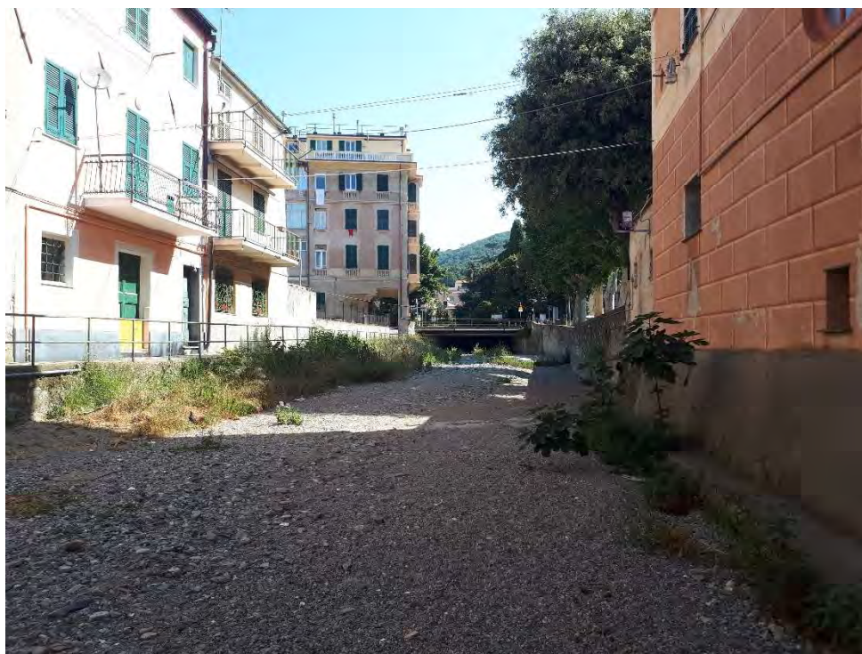
Foto 2.9: Rio Basco a monte dell'attraversamento del ponte medioevale
