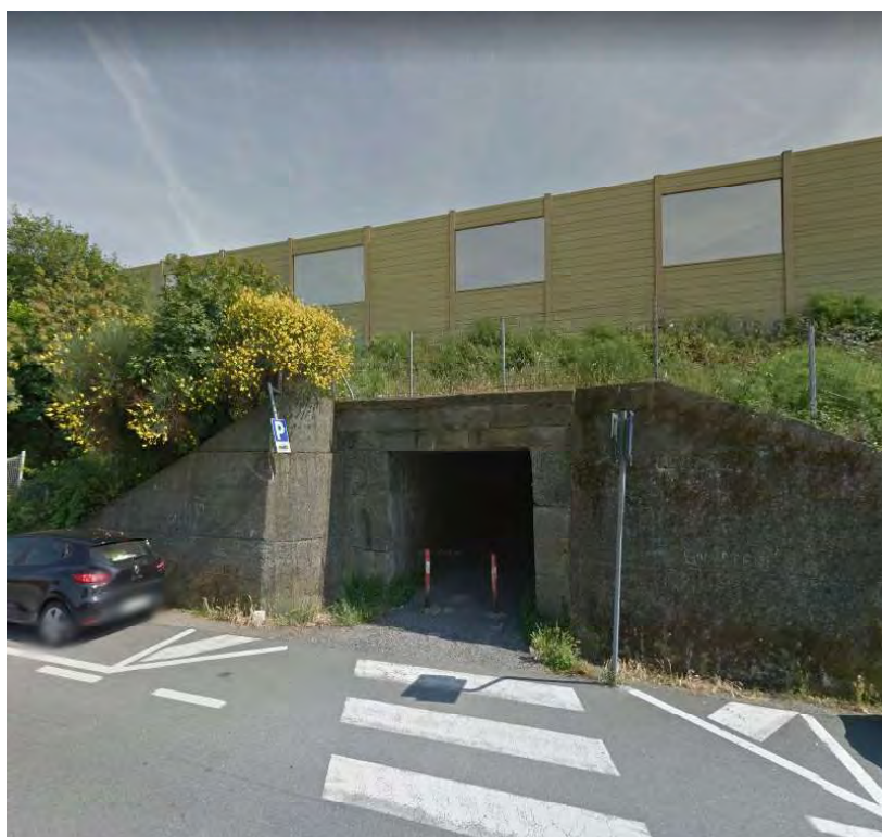
Foto 2.22: Sottopasso pedonale via San Pietro
