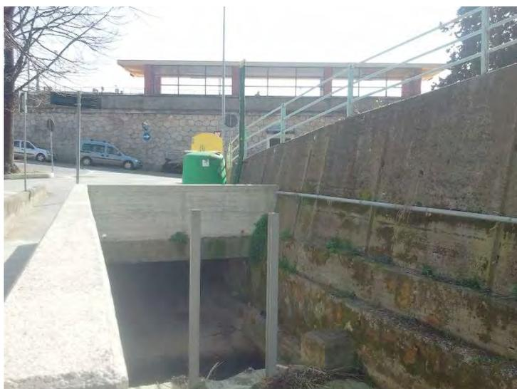
*Figura 2.6.2.6.1 – Rio s. Brigida: sezione di ingresso della copertura.*
