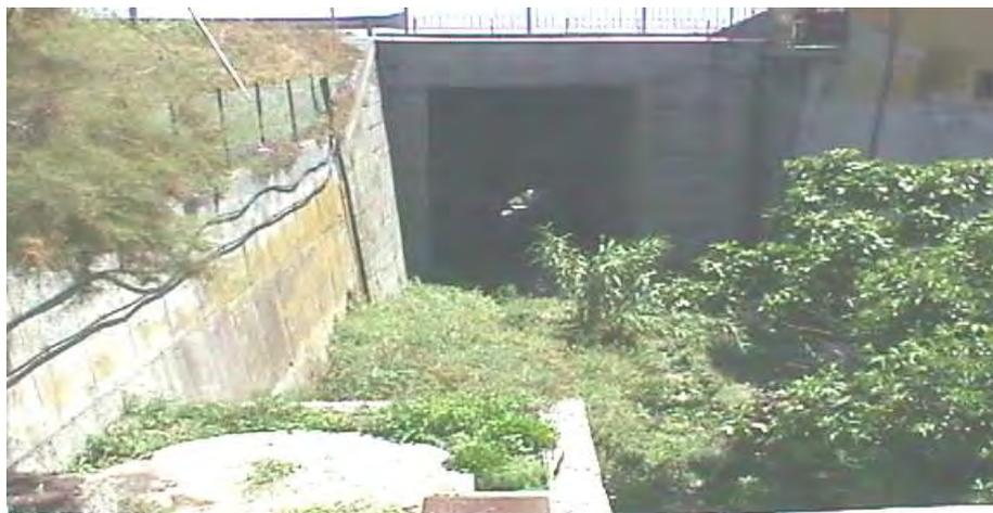
*Figura 2.6.2.2.2 – Rio Presane: ultimo tratto prima dello sbocco a mare. Si noti la presenza dell'impianto di sollevamento della fognatura sulla sinistra, e sullo sfondo la sezione di figura 3.*
