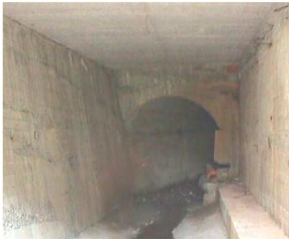
*Figura 2.6.2.17.1 – Rio Carbini: sezione utile per il deflusso della copertura.*
