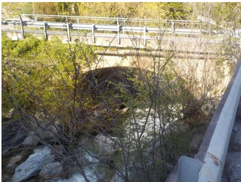
Figura 2 – Vista da monte del ponte SP1 (CLV_3).
