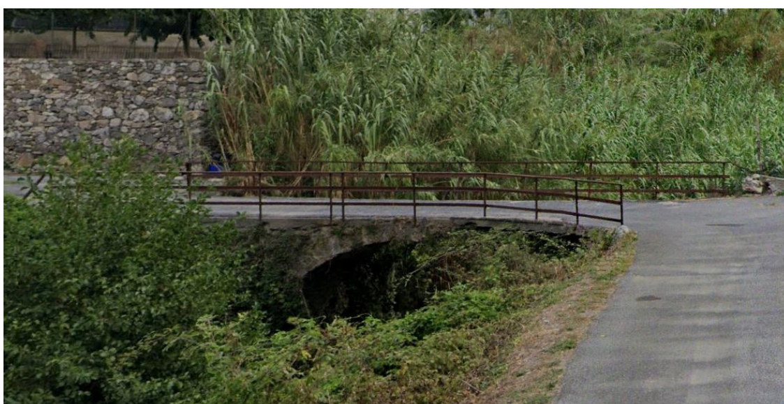
Figura 20 – Vista da monte del ponte di Via Bandiasse (CLV_A2).
