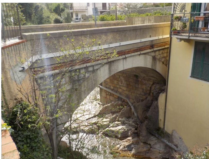
Figura 21 – Vista da valle dell'attraversamento SP60 (CLV_A5).
