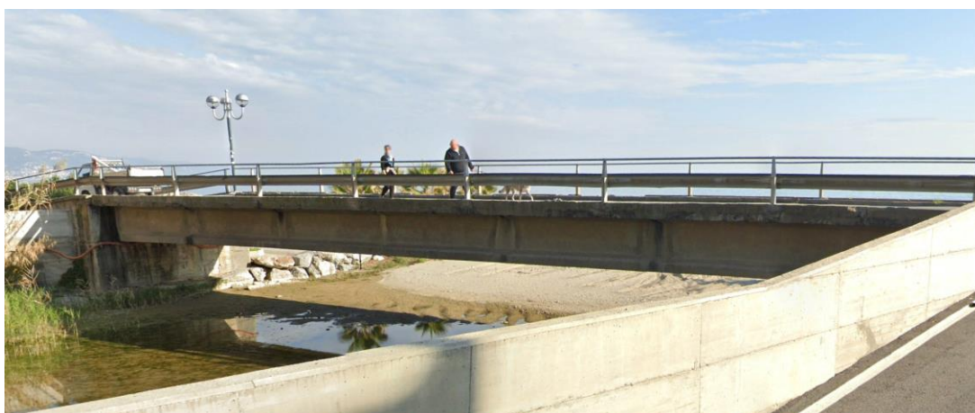
Figura 17 – Vista da monte del ponte via lungomare Matteotti (CLV_47).
