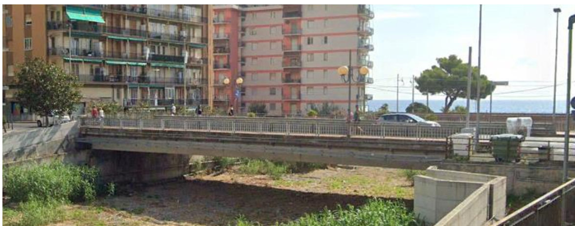
Figura 15 – Vista da monte dell'attraversamento dell'Aurelia SS1 (CLV_45).
