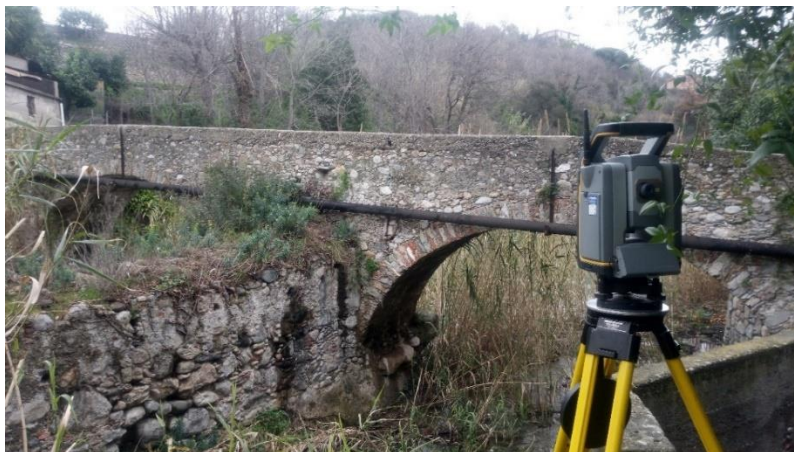
Figura 5 – Vista da monte del ponte Via della Certosa (CLV_8).
