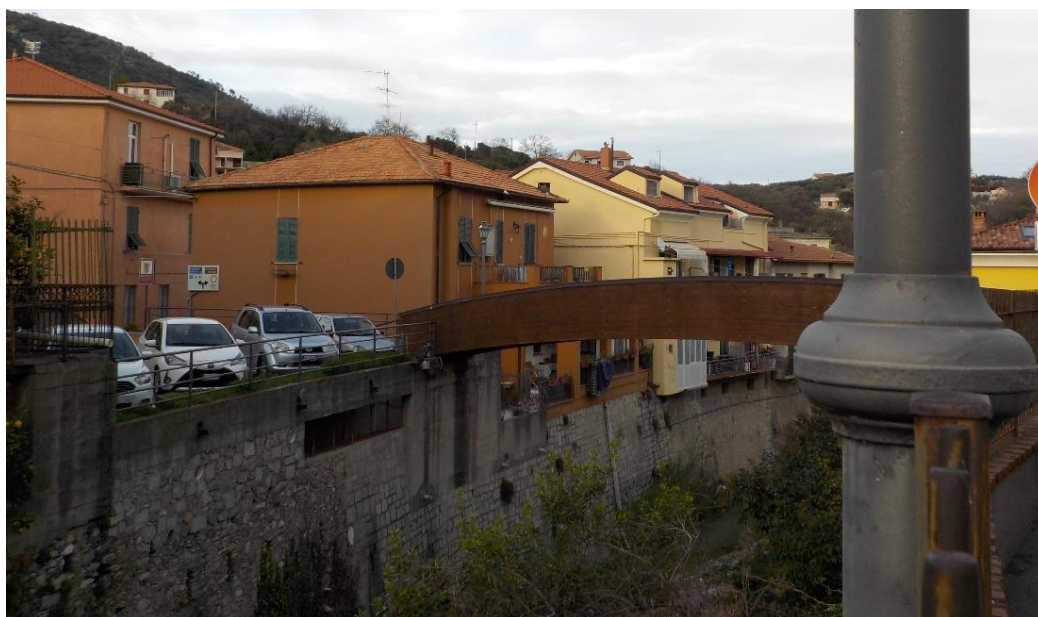
Figura 22 – Vista da monte della passerella pedonale (CLV_A8).
