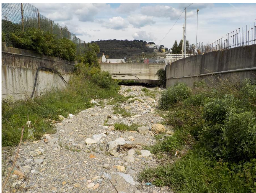
Figura 27 – Vista da monte dell'attraversamento SP60 (CLV_B4_B5).
