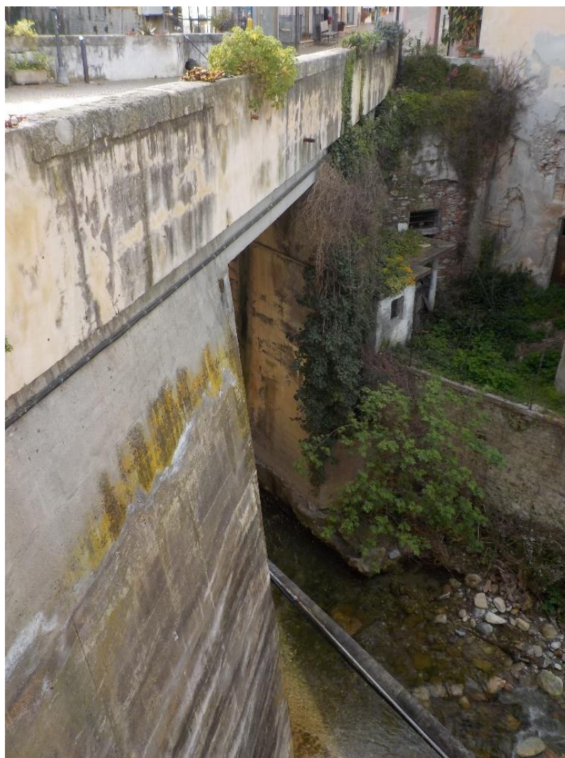
Figura 23 – Vista da valle del ponte di Via Braida (CLV_A11).
