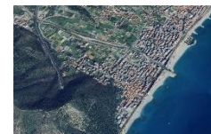
Vista da valle verso monte del tratto terminale del torrente Varatella
