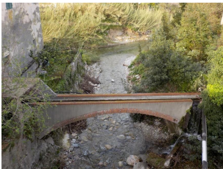
Figura 24 – Vista da monte dell'attraversamento della canaletta dell'acqua (CLV_A12.1).
