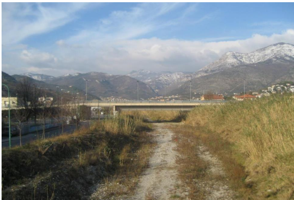
Figura 12 – Vista da monte del ponte Leonardo da Vinci (CLV_41).
