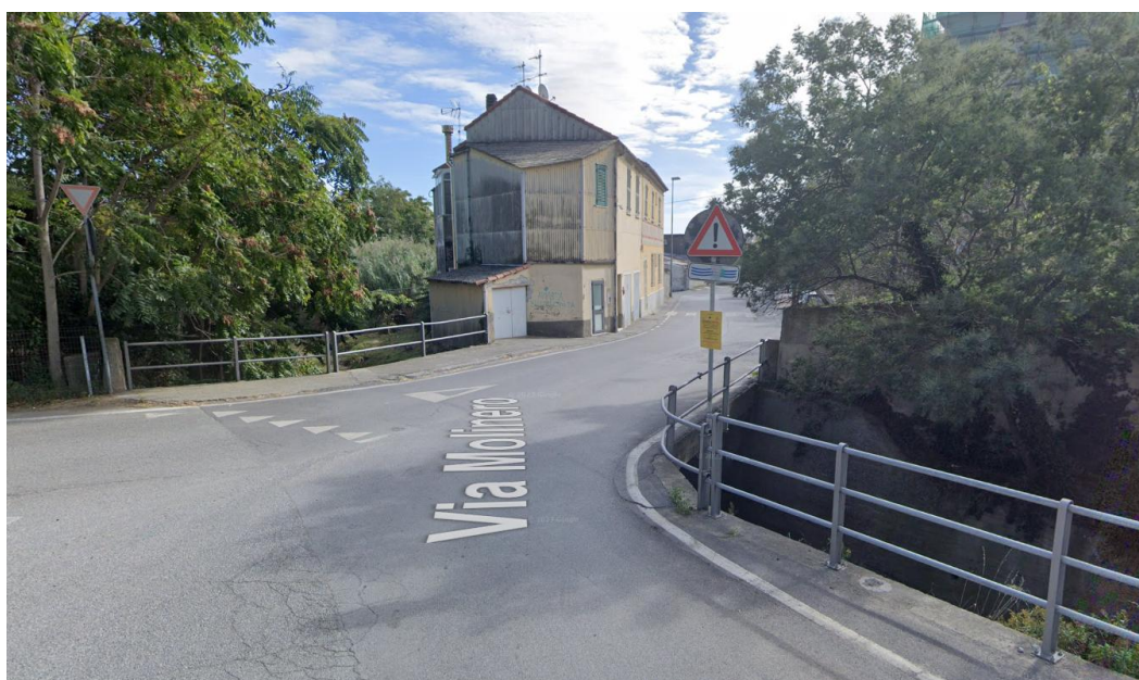
Figura 3-2: Ponte in corrispondenza del viadotto autostradale A10
