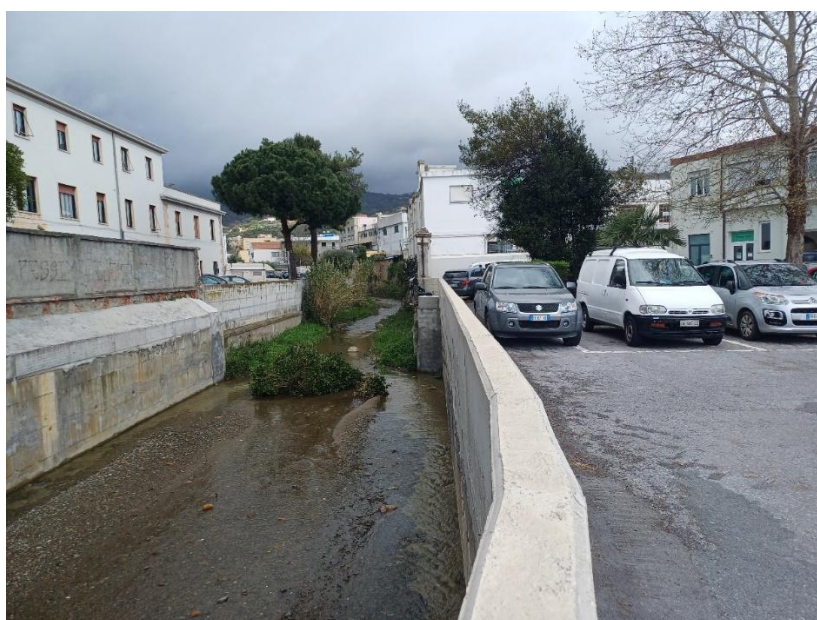
Figura 3-4: Tratto a cielo aperto a monte della tombinatura via Bonini - vista verso monte
