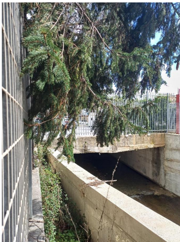
Figura 3-6 - Sbocco tombinatura di via Bonini - vista verso monte
