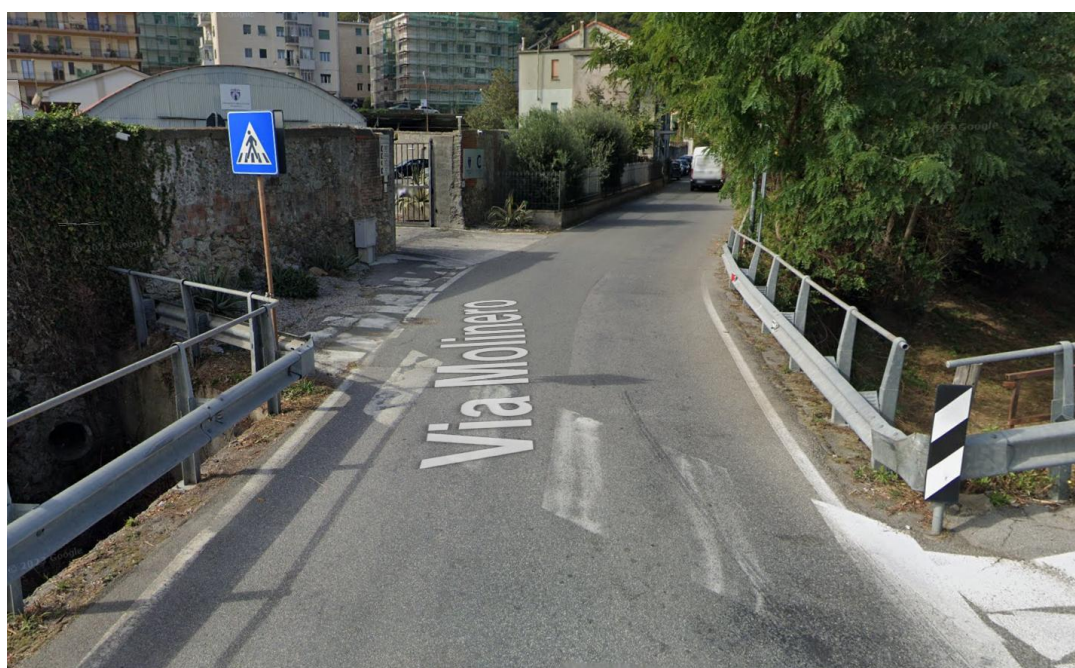
Figura 3-3: Ponte in prossimità del Campus Universitario di Savona
