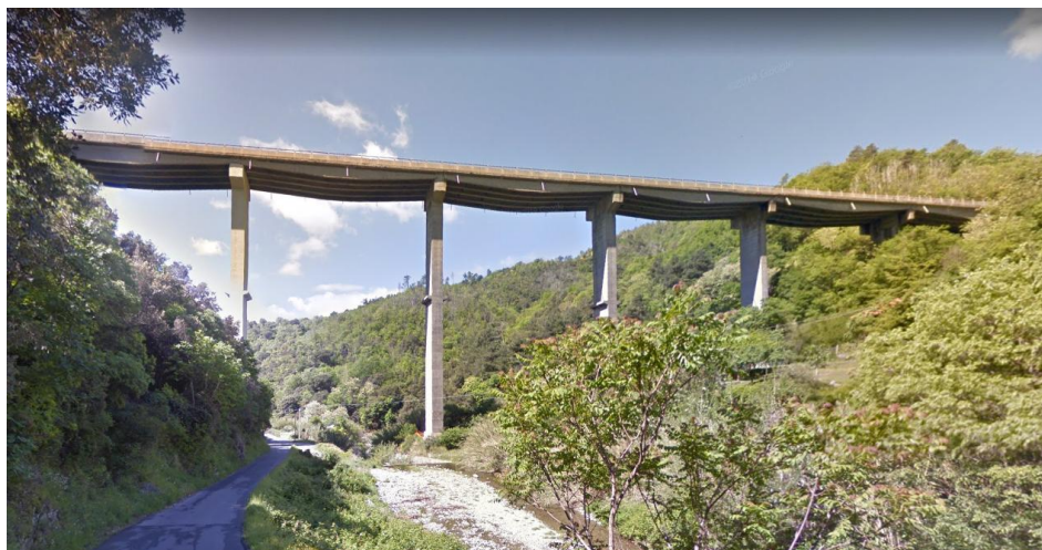
Figura 2.16: viadotto autostradale A6
