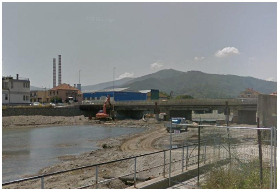
Figura 2.15: ponte stradale Via Aurelia
