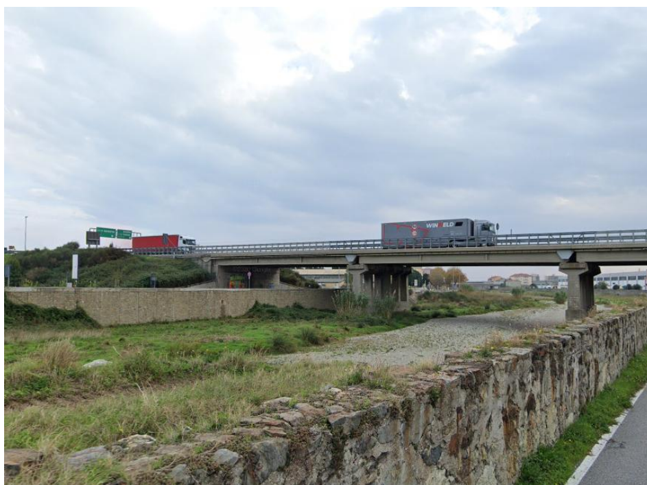
Figura 2.10: Viadotto autostradale A10
