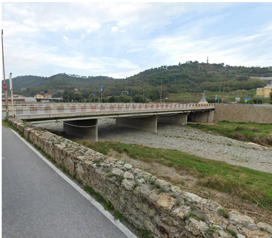
Figura 2.9: ponte di Via San Pietro
