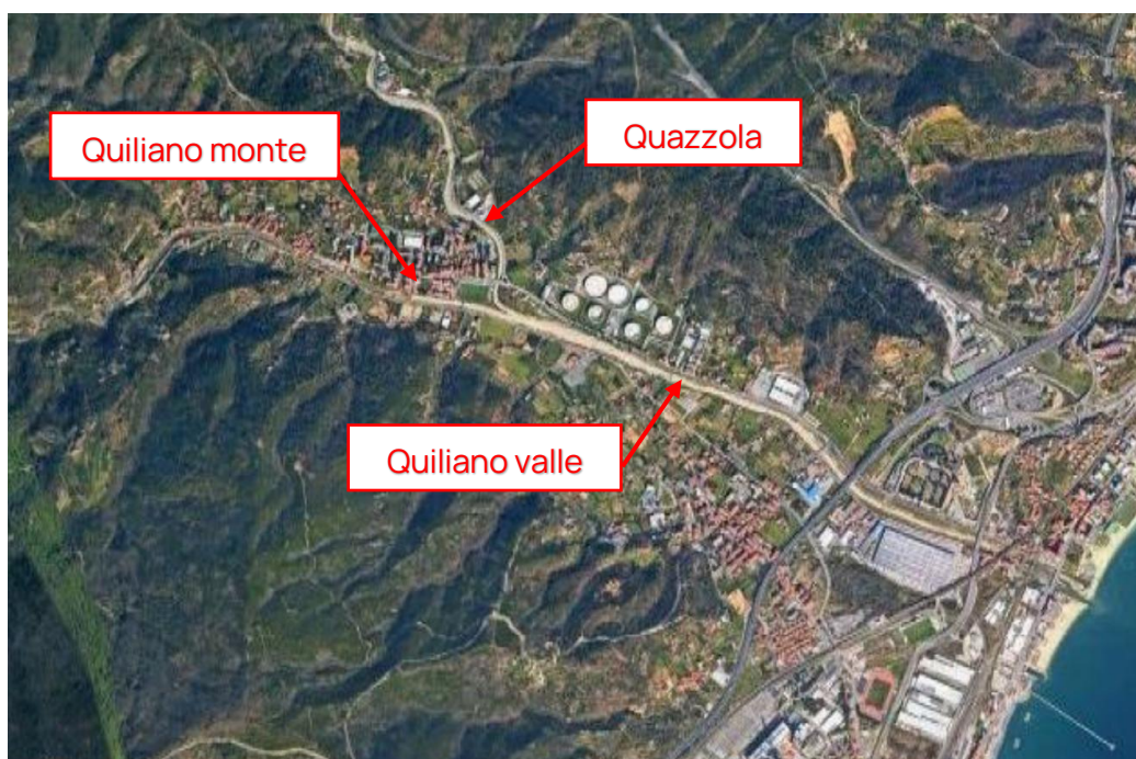
Figura 2-1 – Vista dell'area oggetto di studio da via delle Fabbriche
