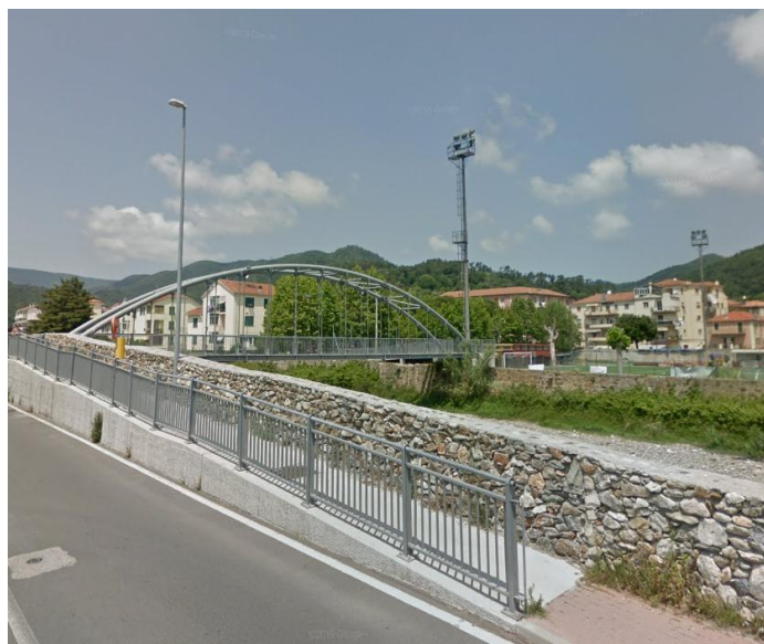
Figura 2.6: passerella pedonale in prossimità del centro sportivo Comunale
