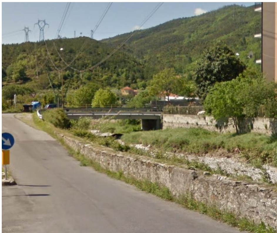
Figura 2.19: ponte di Via Roma
